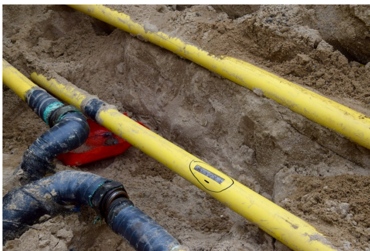
Foto: voorbeeld leidingwerk tank
