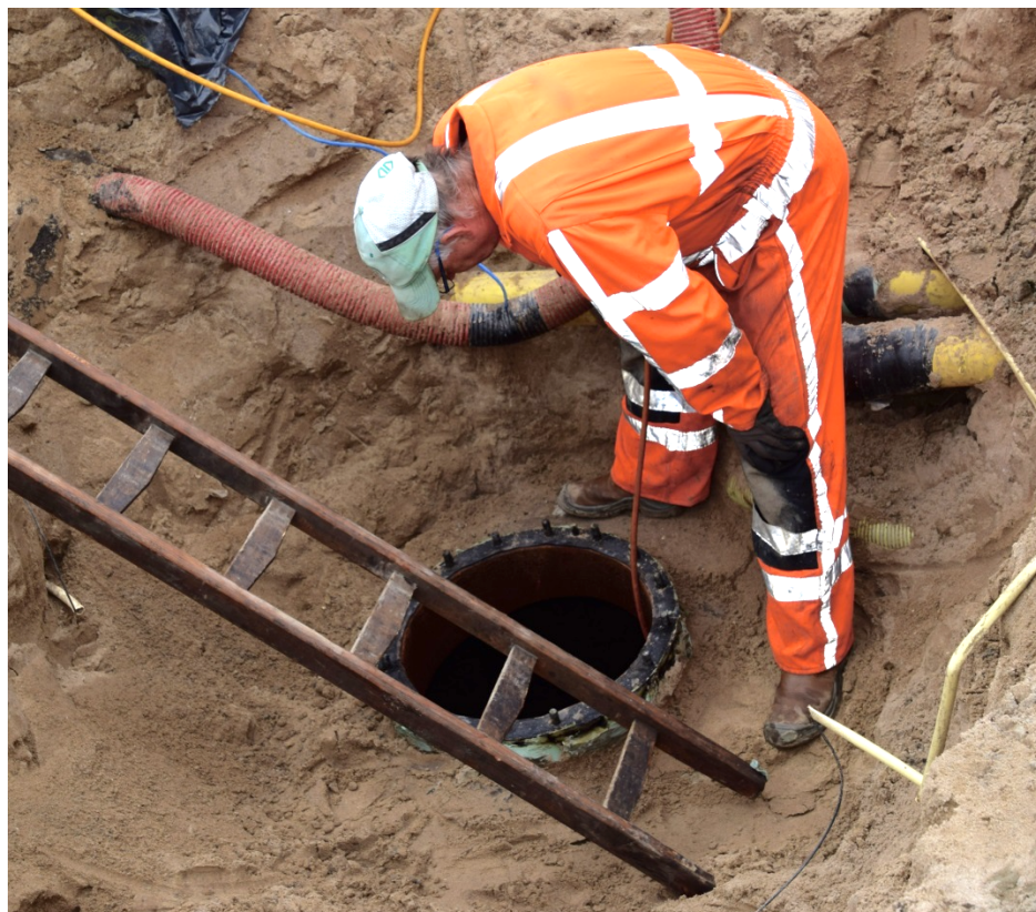
Foto: Mangat tank
