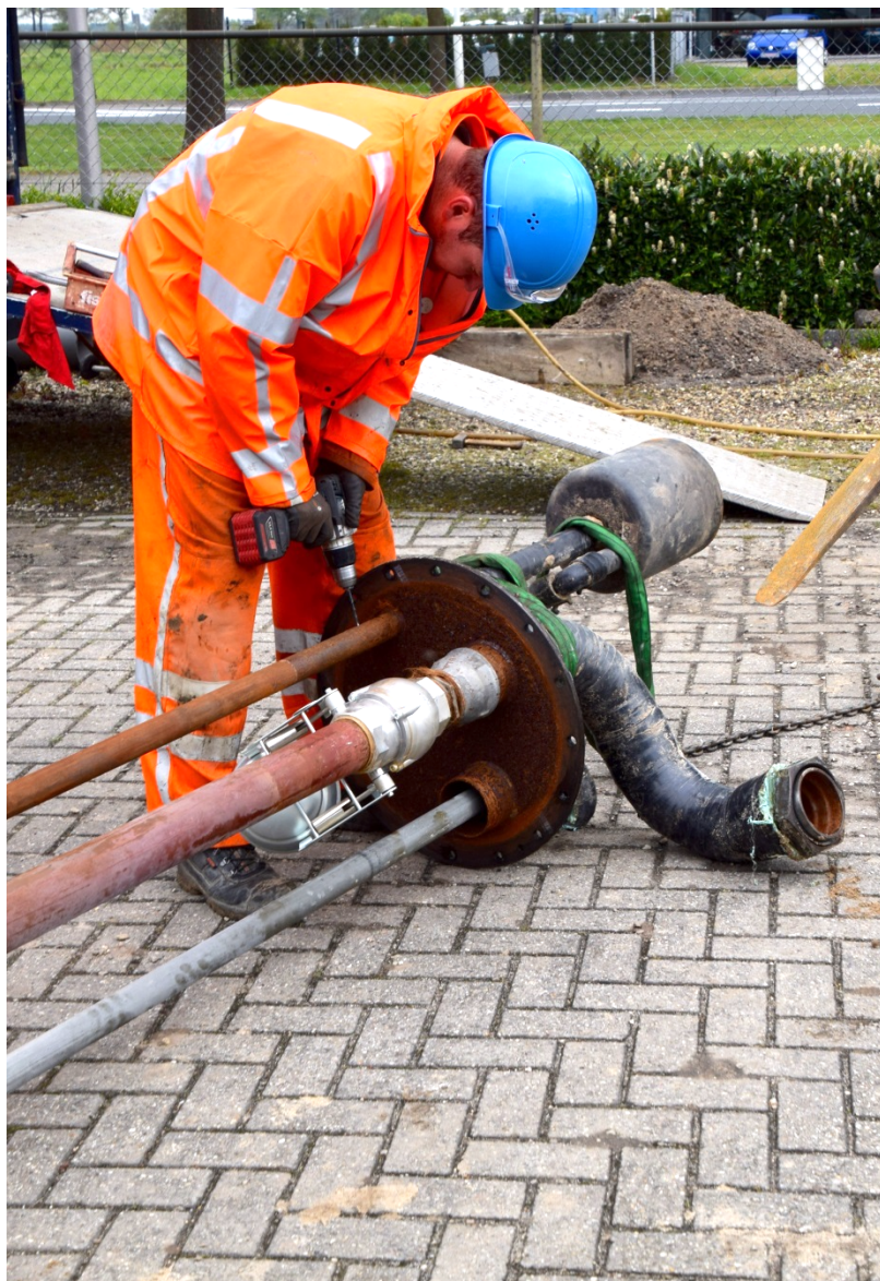
Foto: vaststellen conditie peilleiding
